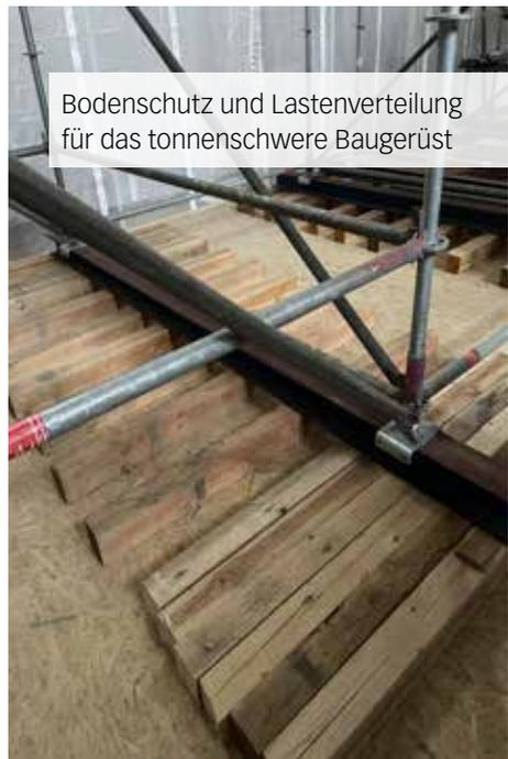
Bodenschutz und Lastenverteilung für das tonnenschwere Baugerüst
